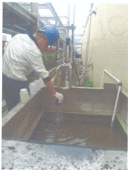
生产废水出口 01#
