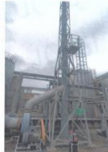
罐区一排气筒出口 05#
